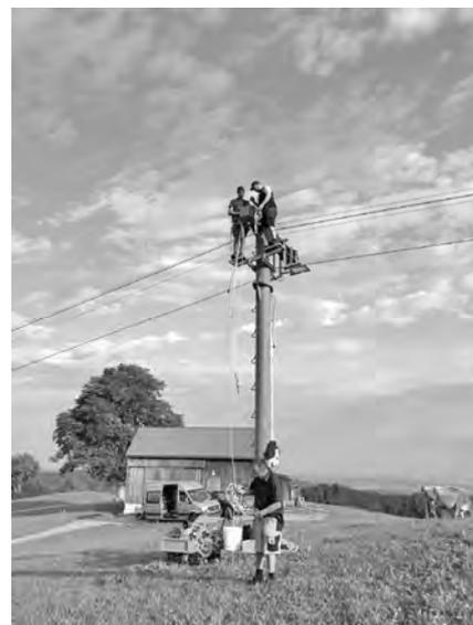
Die revidierten Rollenbatterien werden in luftiger Höhe montiert.
