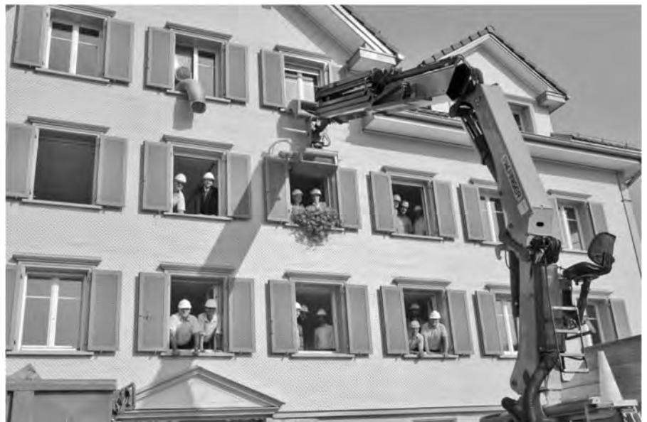
Die am Spatenstich Anwesenden blicken ein letztes Mal aus den Fenstern des dem Abbruch geweihten alten Risi-Hauptgebäudes.
